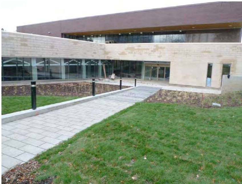
Photo 3 : Corridor piétonnier bien délimité par une bordure d'un côté et du gazon de l'autre côté
