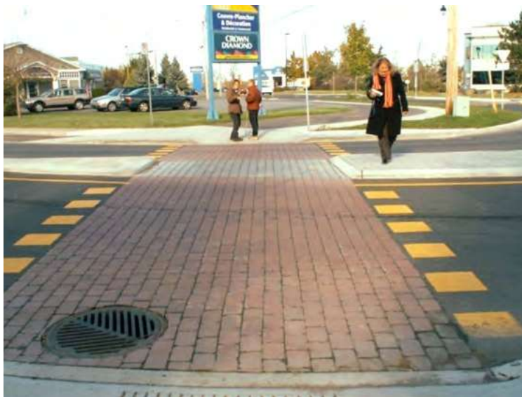
Photo 12 : Les deux segments forment une trajectoire rectiligne, mais l'entrée et la sortie de l'îlot séparateur ne sont pas détectables.
