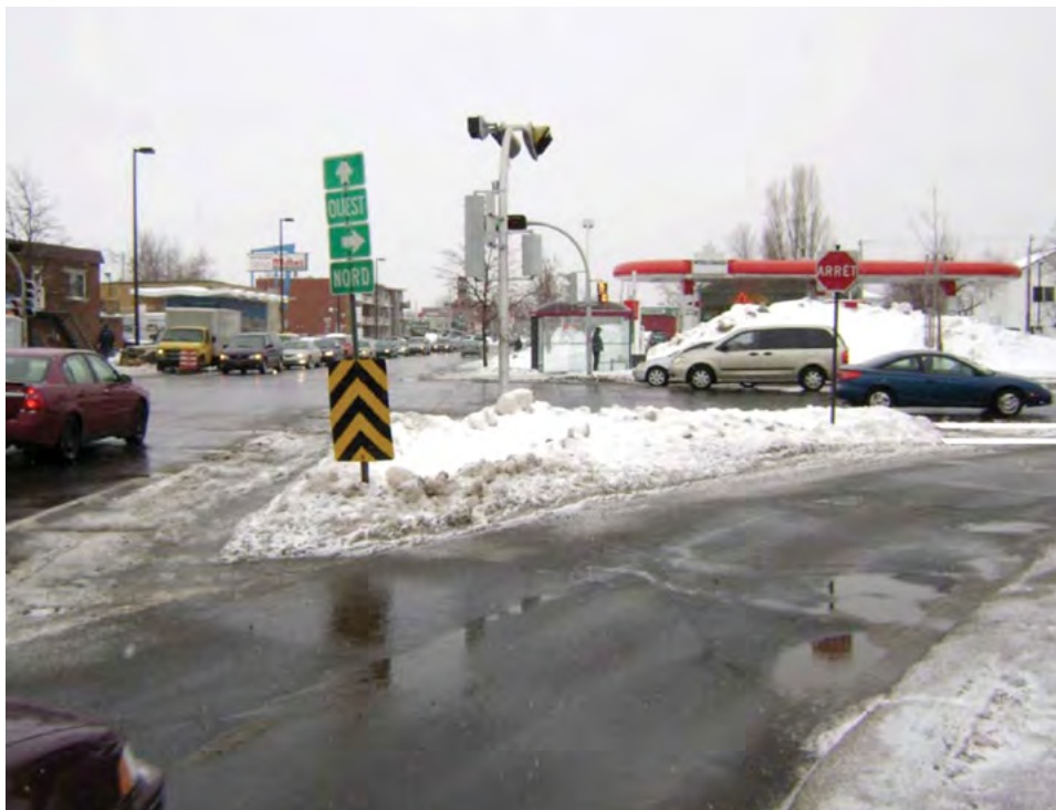
Photo 5 : Bretelle contrôlée avec arrêt et passage en aval
