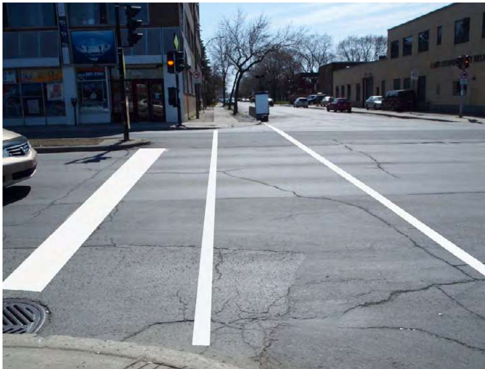
Photo 2a : Terre-plein éloigné du passage pour piétons
