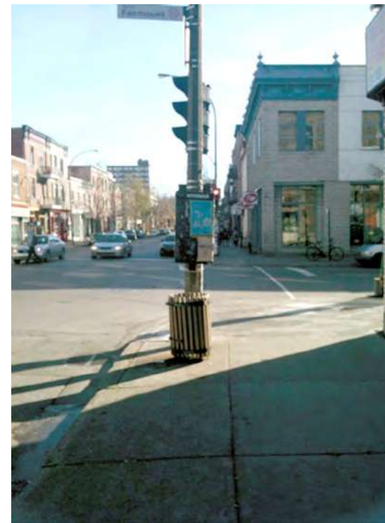
Photo 1b : Espace sous le caisson comblé avec un élément détectable
