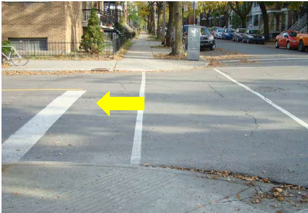
Photo 6 : Passage pour piétons à aligner avec le corridor piétonnier, ligne d'arrêt des véhicules à repositionner
