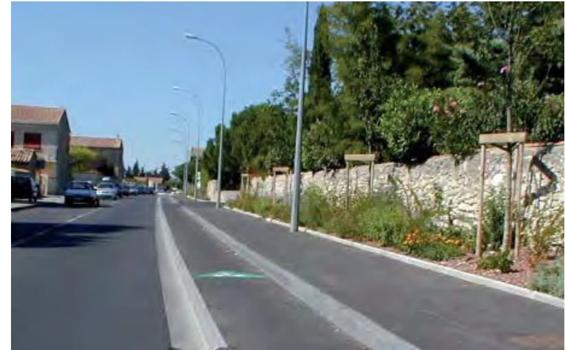
Photo 25 : Piste cyclable, à hauteur intermédiaire entre le trottoir et la rue, dite de Copenhague
