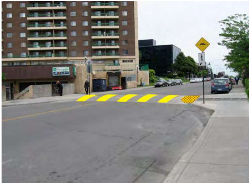
Photo 8a : Passage pour piétons sans contrôle : saillies de trottoir et passage surélevé
