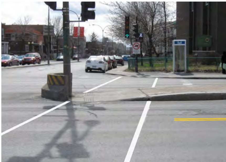
Photo 3 : Terre-plein avec muret de protection, à éviter
