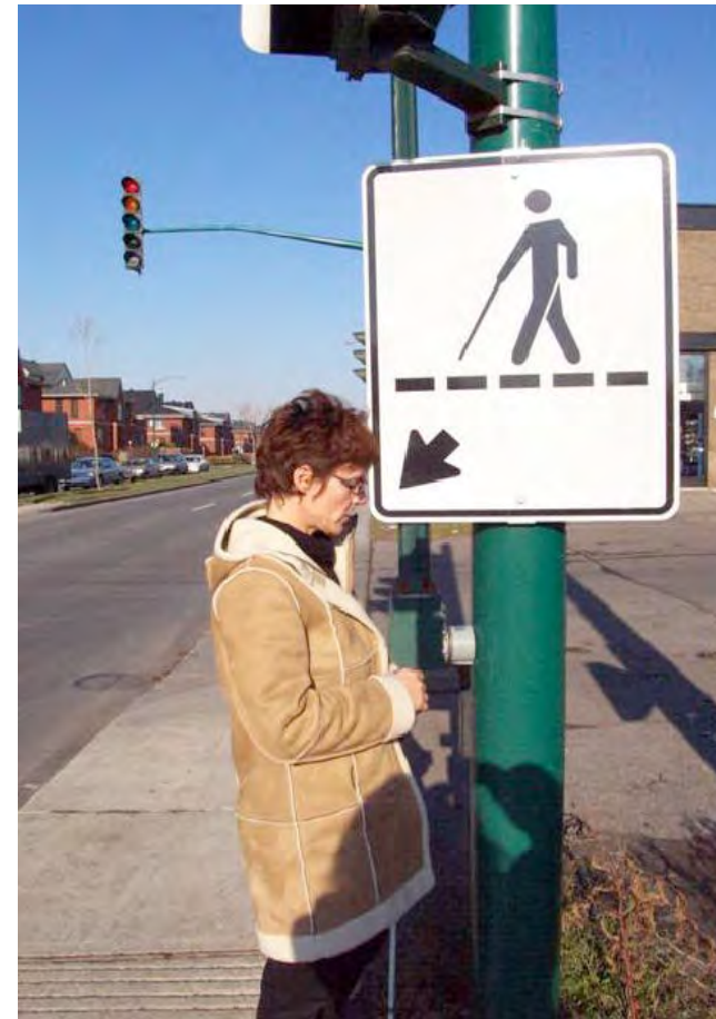
Photo 3 : Risque de blessure créé par le panneau
