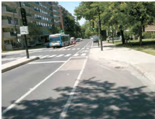
Photo 13a : Ligne d'arrêt des cyclistes en aval de la ligne des véhicules
