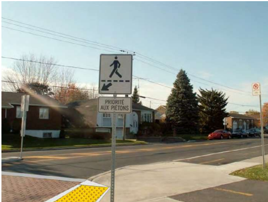
Photo 11 : Panneau de signalisation, passage avec marquage au sol contrastant, bateau pavé avec surface avertissante, élément tactile pour faciliter le maintien de la trajectoire
