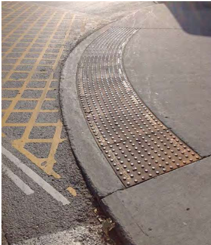
Photo 5 : Surface avertissante détectable tactilement et visuellement
