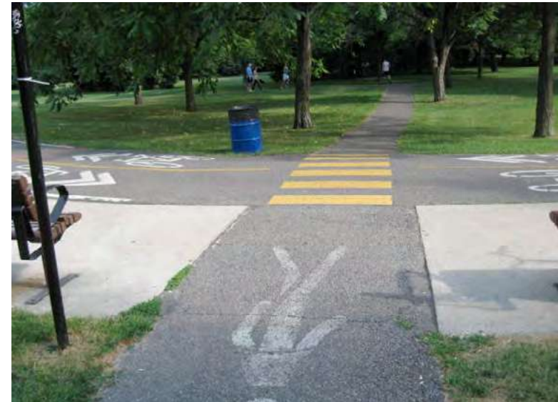
Photo 5 : Marquage signalant un corridor piétonnier
