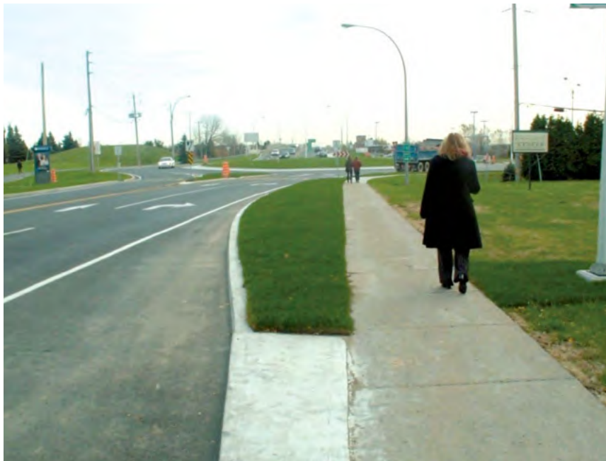
Photo 10 : Aménagement d'une surface gazonnée côté rue à l'approche du carrefour giratoire
