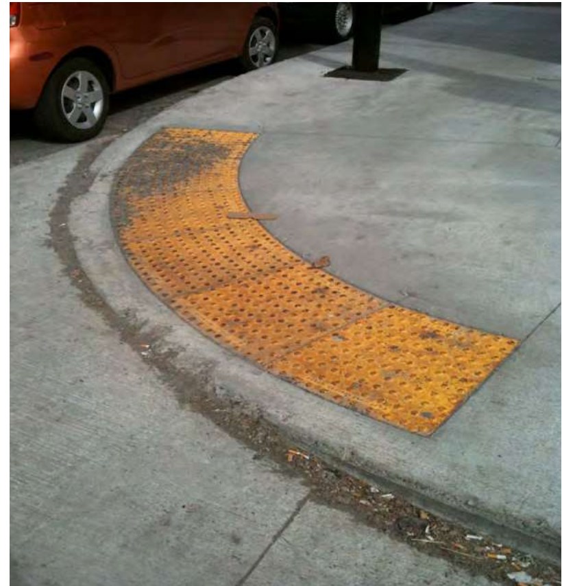
Photo 7 : Bateau pavé muni d'une surface avertissante
