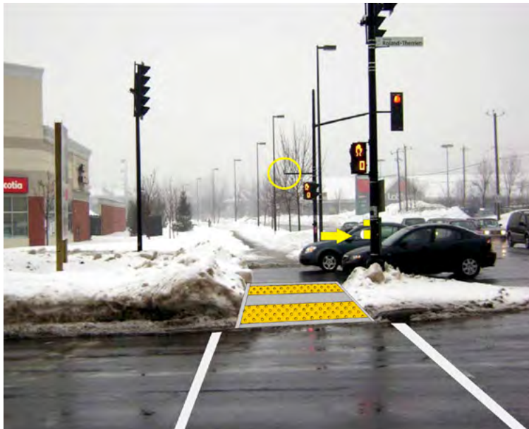
Photo 4 : Traversée en un temps, bouton d'appel disponible sur le refuge, surfaces avertissantes, mais zone adjacente mal dégagée
