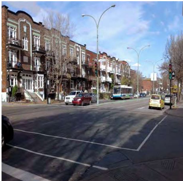
Photo 1 : Feux pour piétons simultanés à l'axe principal
