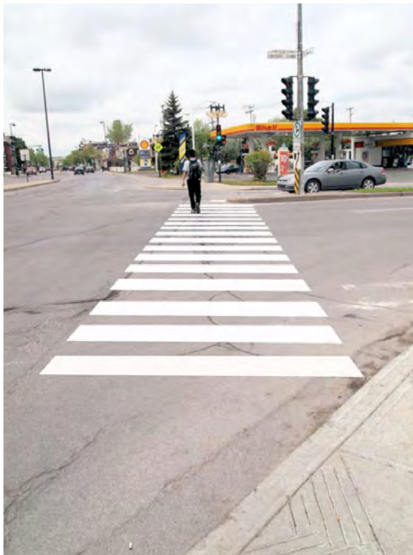
Photo 2b : Terre-plein empiétant dans le passage pour piétons
