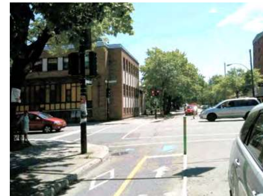
Photo 13c : Poteau séparateur installé près de la ligne d'arrêt des cyclistes
