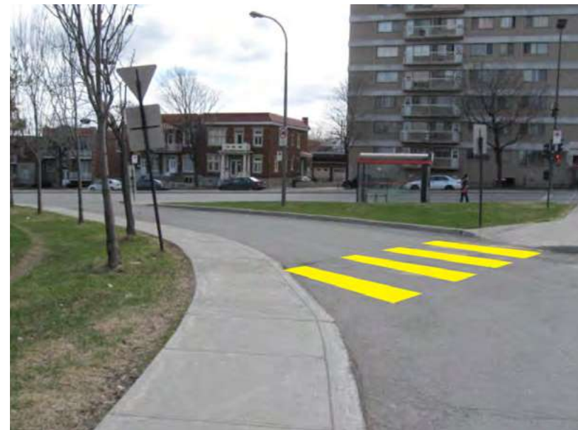
Photo 6 : Passage pour piétons non parallèle avec la voie routière
