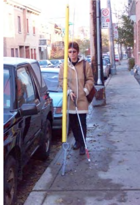
Photo 7 : Hauban oblique constituant un obstacle dangereux
